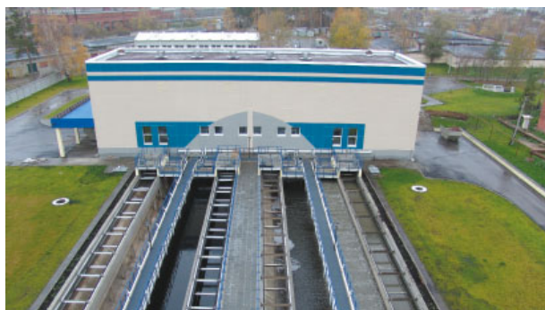
Рис. 2. Новые песколовки и здание решеток
