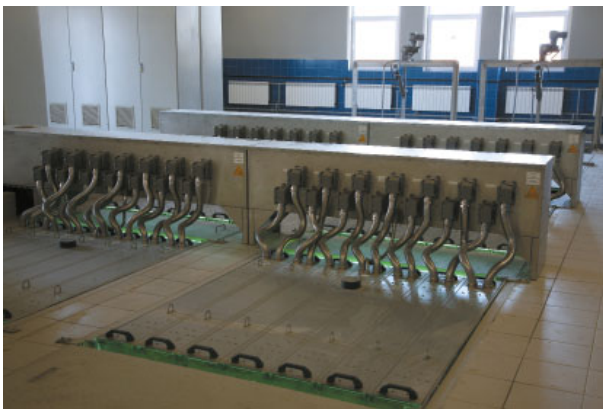
Рис. 4. Установки УФ ОБЕЗЗАРАЖИВАНИЯ КАНАЛЬНОГО ТИПА
