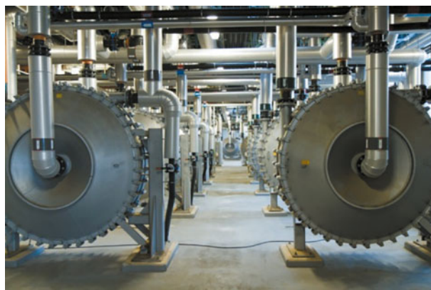
Рис. 2. Внешний вид спиральных теплообменников
