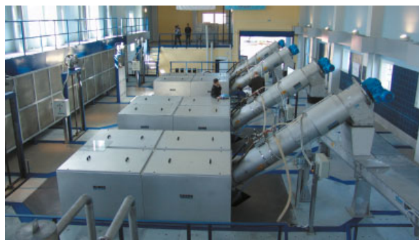
Рис. 3. В здании решеток: оборудование типа ROTAMAT
